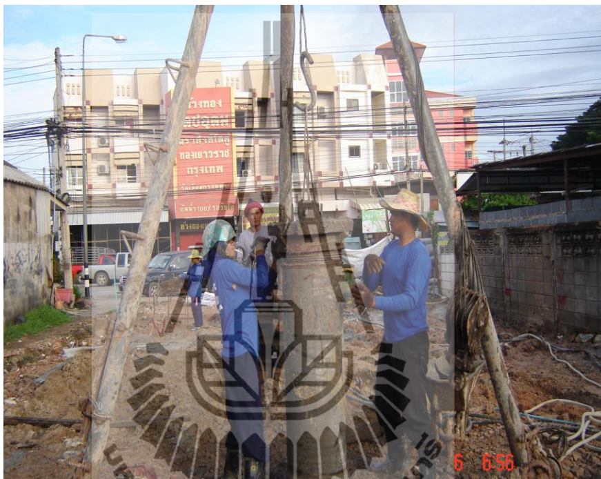
รูปที่ 2.31 PUT CASING IN TO STABLE CLAY การตอกปลอกเหล็ก (Casing)
