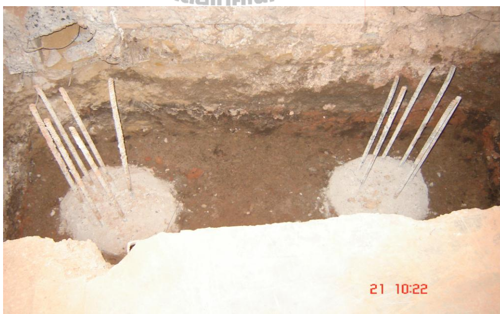
รูปที่ 2.36 COMPLETED PILE เมื่อคอนกรีตได้อายุแล้ว ต้องสกัดหัวเสาเข็มเจาะให้เรียบ และสูงกว่าระดับได้ฐานราก ประมาณ 5-7 ซม.
