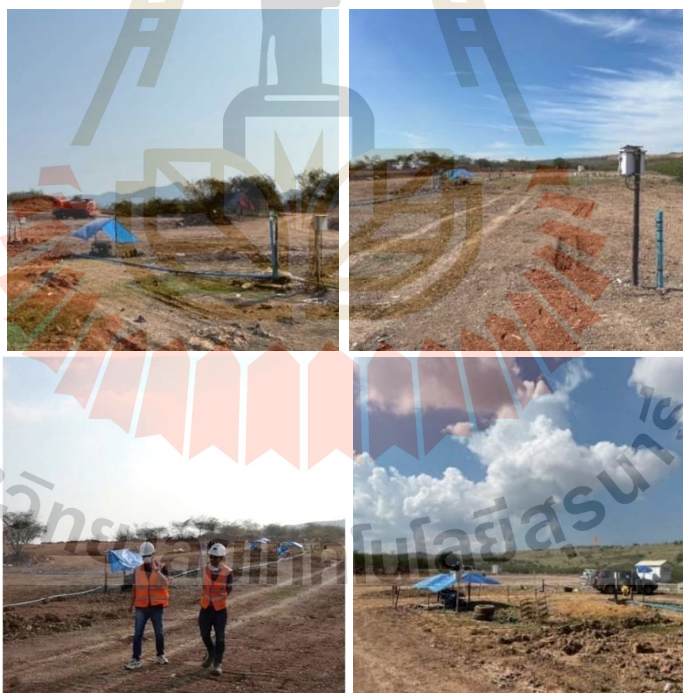
รูปที่ 3.15 วางท่อระบายน้ำแนวราบ และทำความสะอาดบริเวณพื้นที่ทดสอบ
