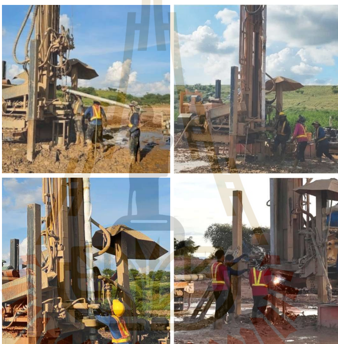
รูปที่ 3.12 เมื่อดำเนินการขุดเจาะถึงระดับ 123 เมตร ทำการติดตั้งท่อเหล็ก มอก. ขนาด 101.6 มม. ที่พื้นรอบด้วยแผ่นใยสังเคราะห์ Geotextile
