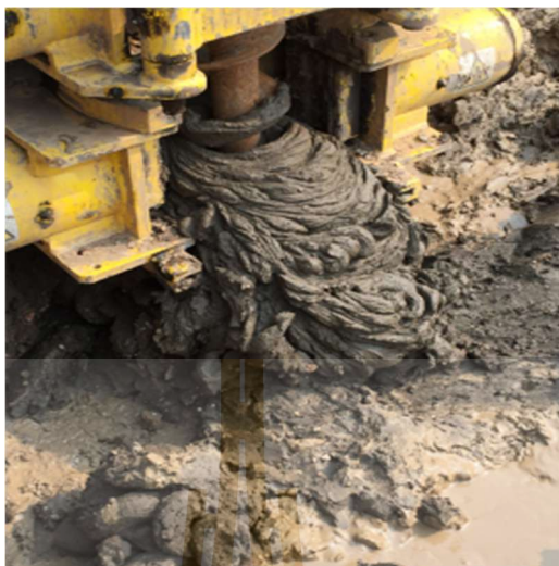
รูปที่ 1.3 ดินเหนียวที่พบบริเวณฐานของลาดดินถม
