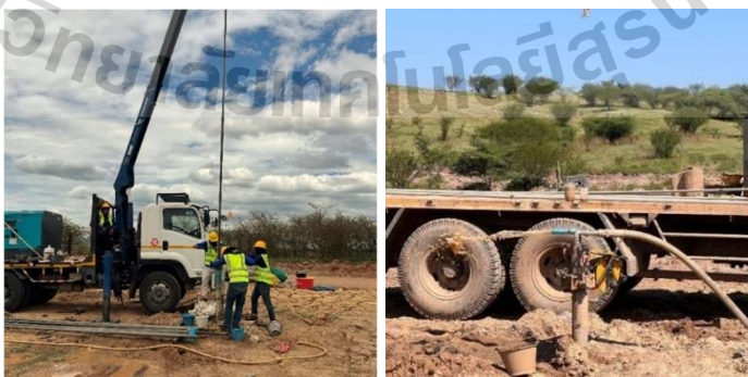
รูปที่ 3.13 ดำเนินการเป่าล้างท่อและทดสอบการสูบน้ำ ก่อนการติดตั้งปั๊มสูบ
