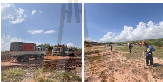
รูปที่ 3.8 เตรียมพื้นที่บริเวณงานก่อสร้างขุดเจาะ
