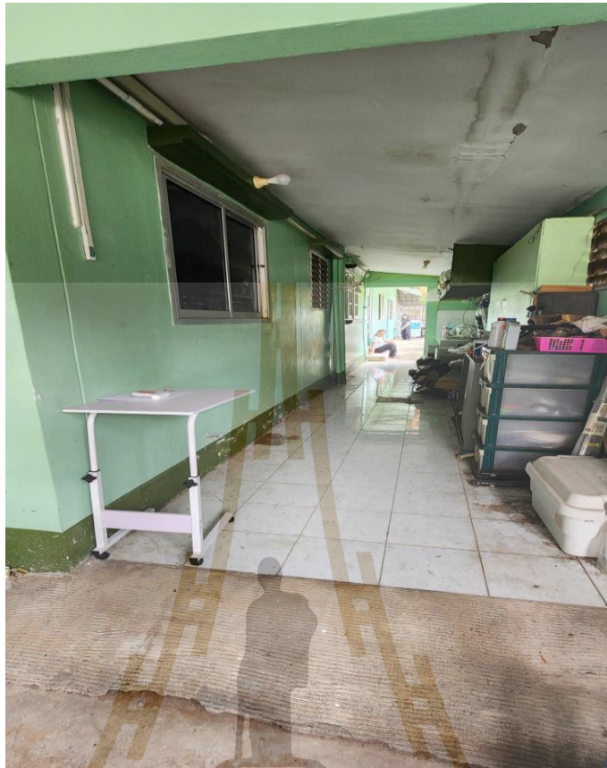
รูปที่ 3.5 ตัวอย่างพื้นที่ที่ทดลองภายนอกอาคาร
